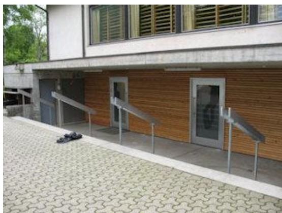
le vestiaire avec douches et wc
